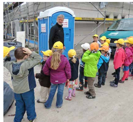
Evang. Kindertagesstätte Fischbach. Unsere Kita-Baustelle ist spannend – bei jedem Besuch
